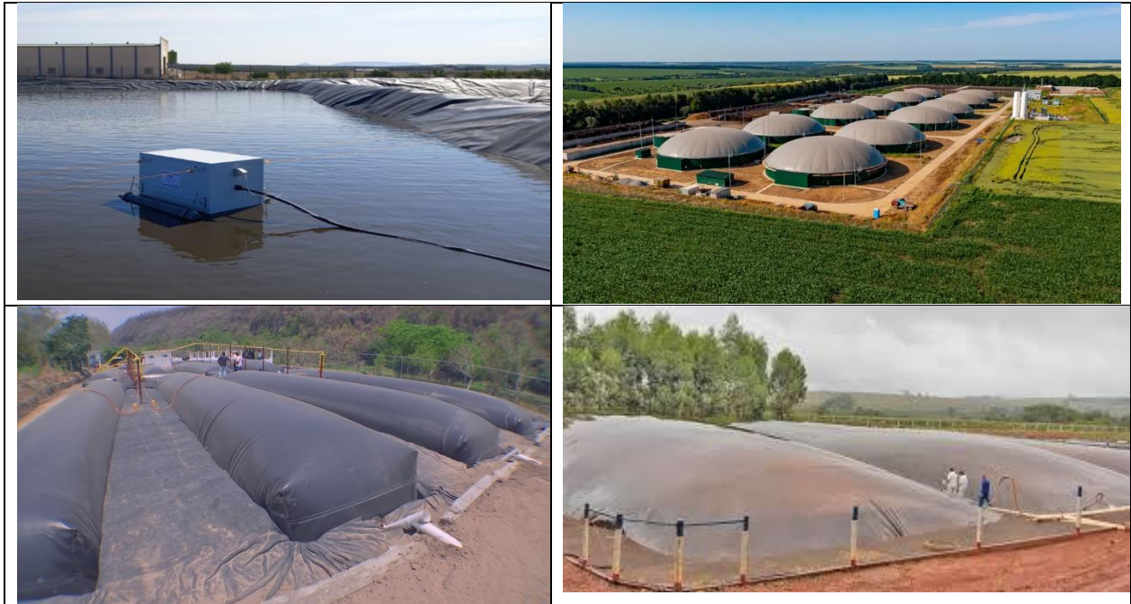
Aireador de laguna abierta. Biorreactores en Brasil. Biogás en Veracruz, México. Otras lagunas anaeróbicas para capturar gas metano producido.
